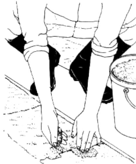
6. ใช้ดินผสมโรยระหว่างรอยต่อของแผ่นหน้า แล้วใช้สันคราดเกลี่ยให้เรียบ
