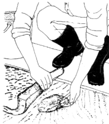
3. ควรปูพรมให้รอยต่อสลับกับเหมือนการทออิฐ
